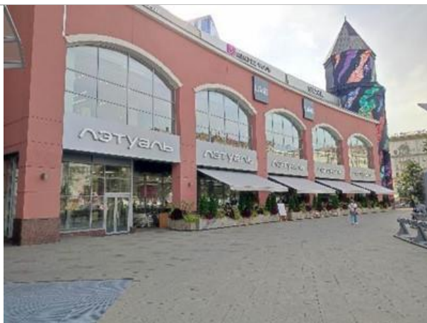
Фотография 3.2. Внешний вид здания
