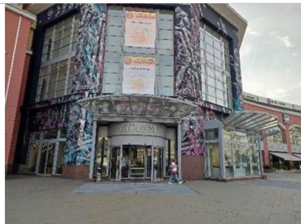
Фотография 3.1. Внешний вид здания
